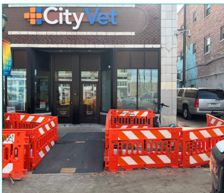
Rampa para mantener el acceso a los negocios
